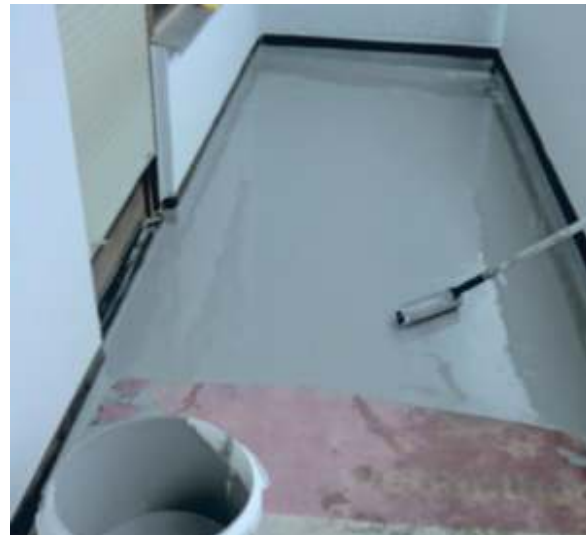
Beim Einbringen der Dichtschicht mit Gewebeeinlage ist Know-how gefragt
