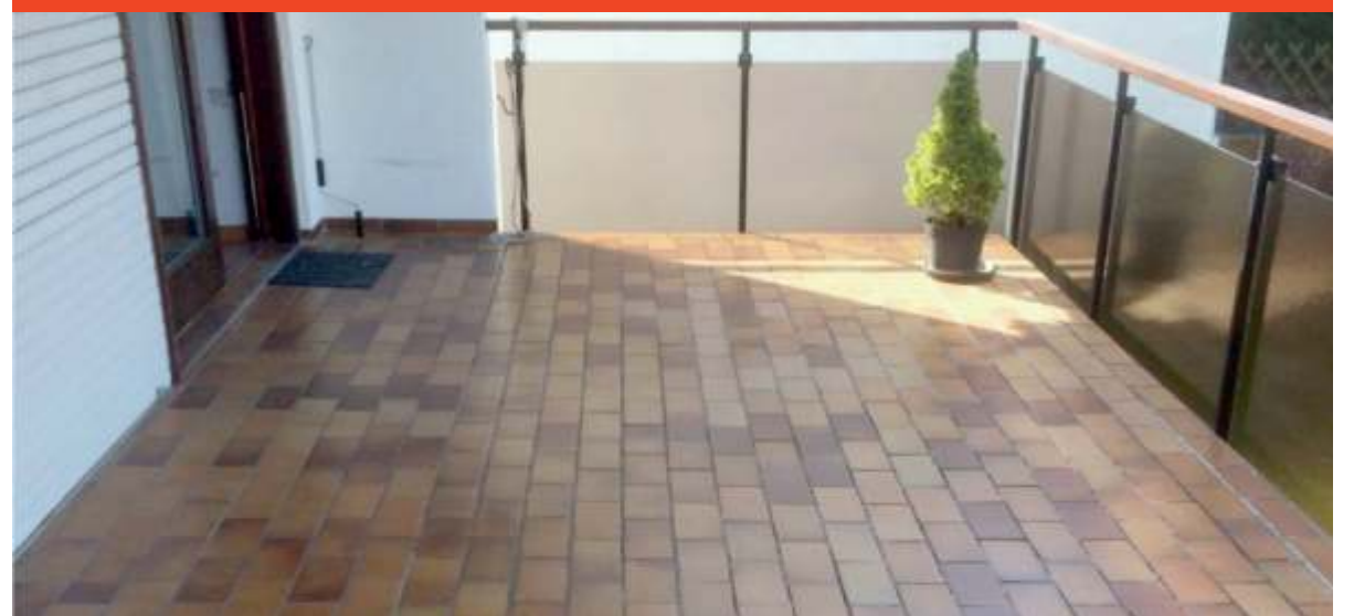
Alte Platten sind durch Feuchtigkeit und Frost beschädigt
