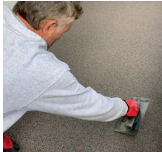
Die Colorquarz-Beschichtung wird von Hand gespachtelt
